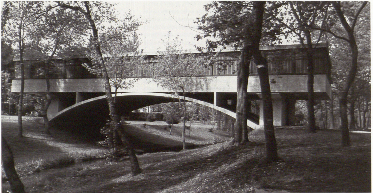
La casa, estructura limpia de hormigón. The house, clean concrete structure.
